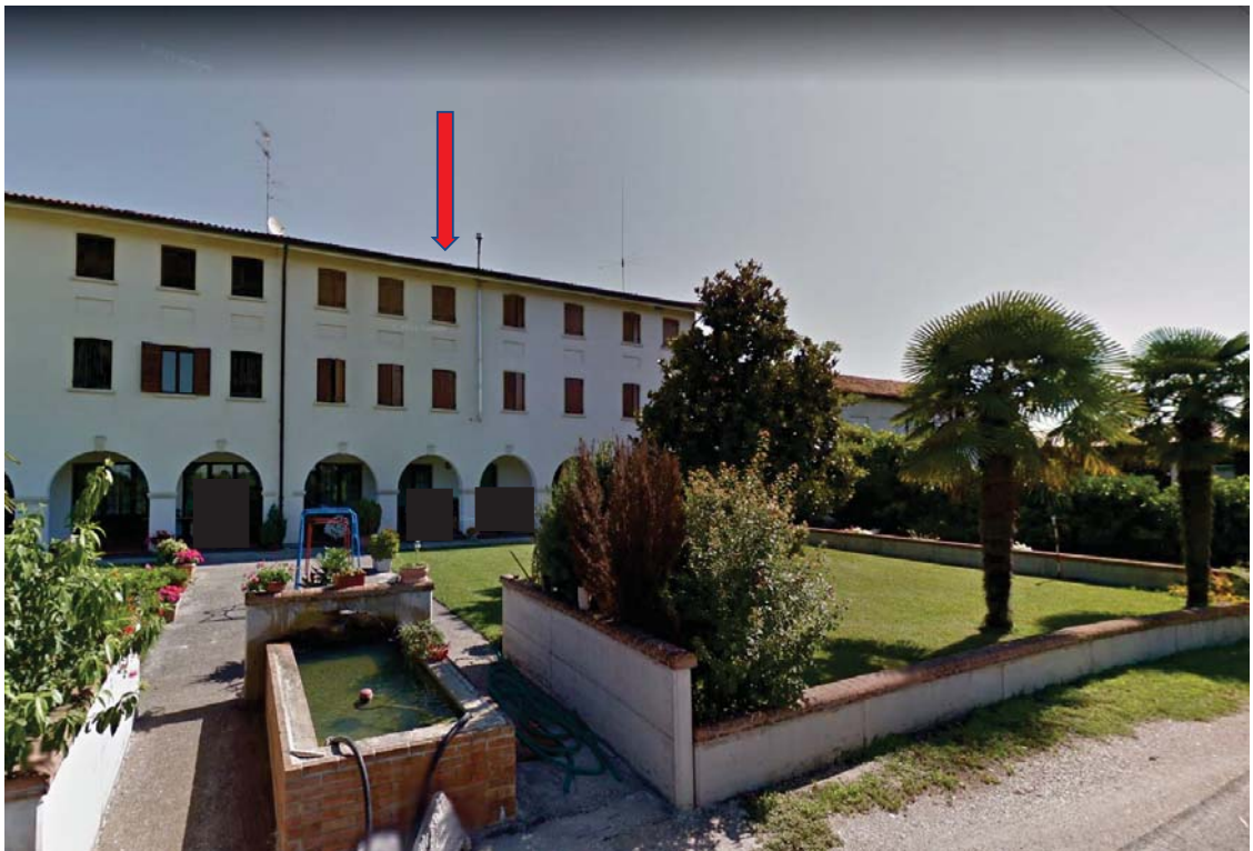
Foto 6 – Vista fabbricato ad uso misto residenziale e rurale in Via Pra Gatta n. 4
